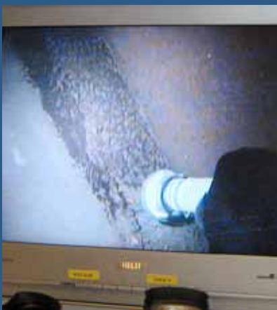
På skærmen inde i den grønne lastbil, kan man via dykkerens kamera følge med i støvsugningen
